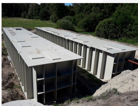
ČIŠTĚNÍ ODPADNÍCH VOD
