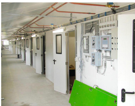
CHODBA S VNITŘNÍMI DVEŘMI A OKNY
