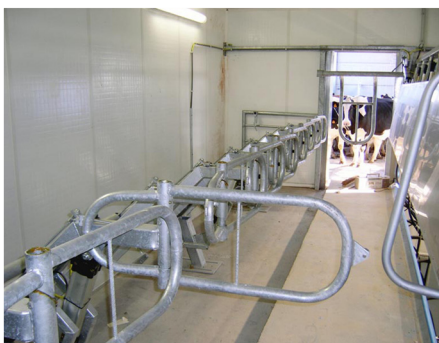
PROTECCIÓN DE PARED EN SALA DE ORDEÑO
