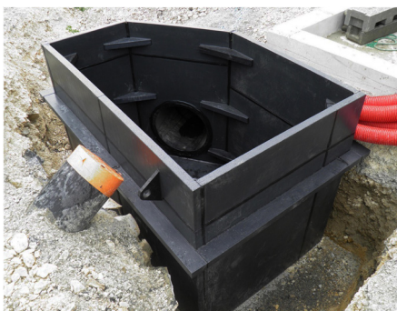
DEPÓSITO DE AGUA DE LLUVIA
