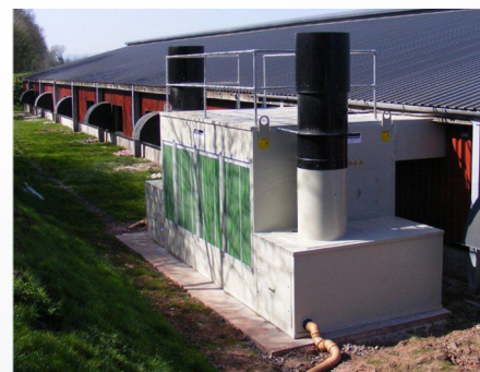
DEPURADOR DE AIRE
