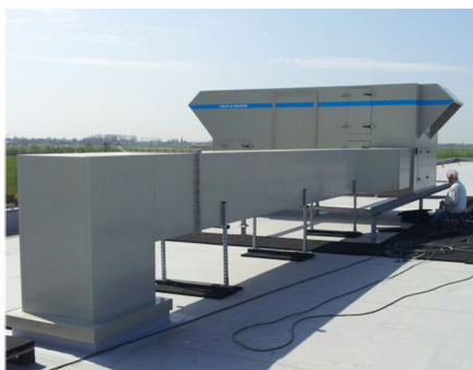
CONDUCTO DE VENTILACIÓN
