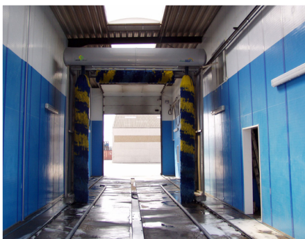
REVESTIMIENTO DE PAREDES
