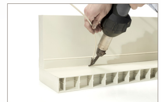
SOLDADURA CON VARILLA
