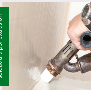
soldadura por extrusión
