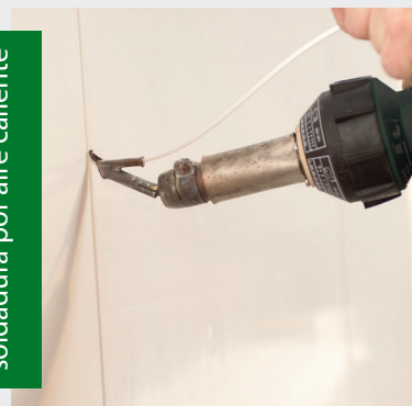
soldadura por aire caliente
