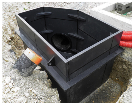
RÉCUPÉRATEUR D'EAUX PLUVIALES
