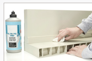
DÉGRAISSAGE ET NETTOYAGE DE LA SURFACE
