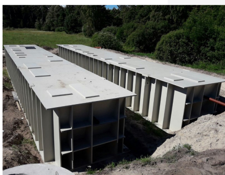
ČISTENIE ODPADOVEJ VODY
