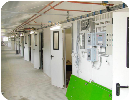
Gang mit Innentüren and -Fenstern
