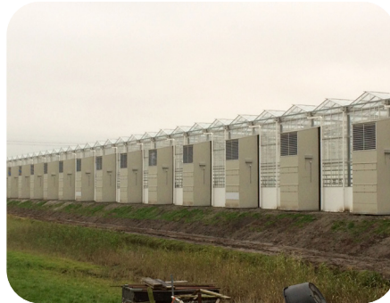
Wärmerückgewinnungsanlage
