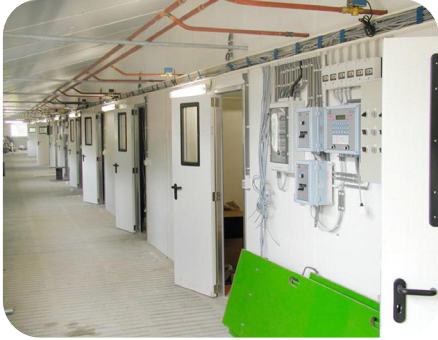
Couloir avec portes et fenêtres intérieures
